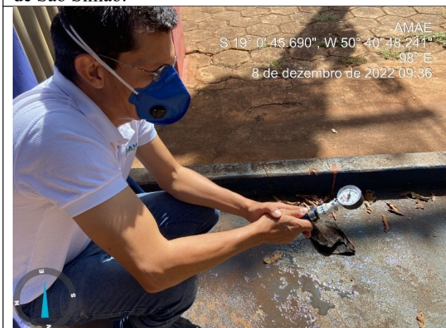
Autor: AMAE Descrição: Equipe da AMAE realizando aferição de pressão em rede de distribuição de água, no distrito Itaguaçu – GO.
